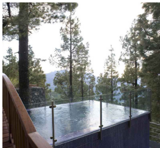
Piscina térmica del Parador de Tejeda
